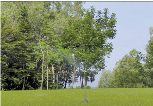
推動中水回收再利用裝置
