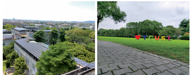
屋頂建置太陽能光電系統
